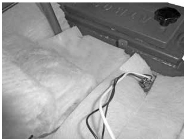
Hülse für Thermostate (Fühler)
